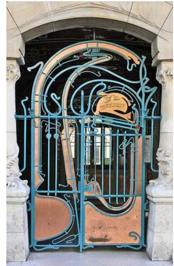
Grille d'entrée, Castel BERANGER, HECTOR GUIMARD, 1895-1898,
